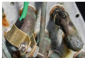
Instalación de sensor de temperatura de la QwikSwap® en la serpentinas
